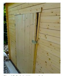
Fig. 15.3.4.1: Warped door
